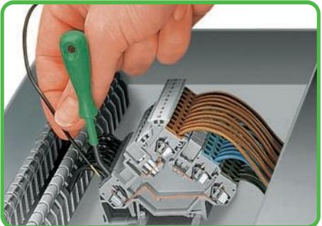
Подключение проводника кабеля с помощью углового рабочего инструмента (210-658).
