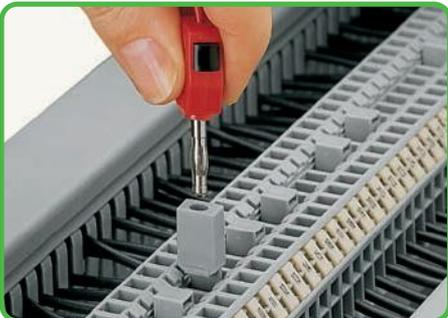
Измерение с помощью тестового адаптера.
